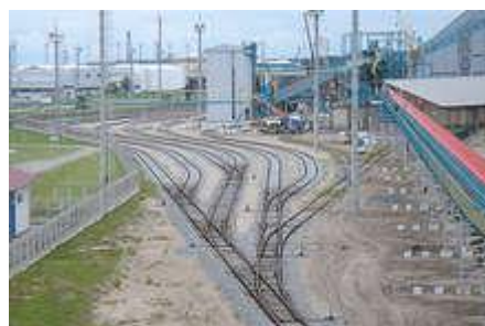
Железнодорожная инфраструктура терминала позволяет принимать на собственные подъездные пути составы по 56 вагонов.
